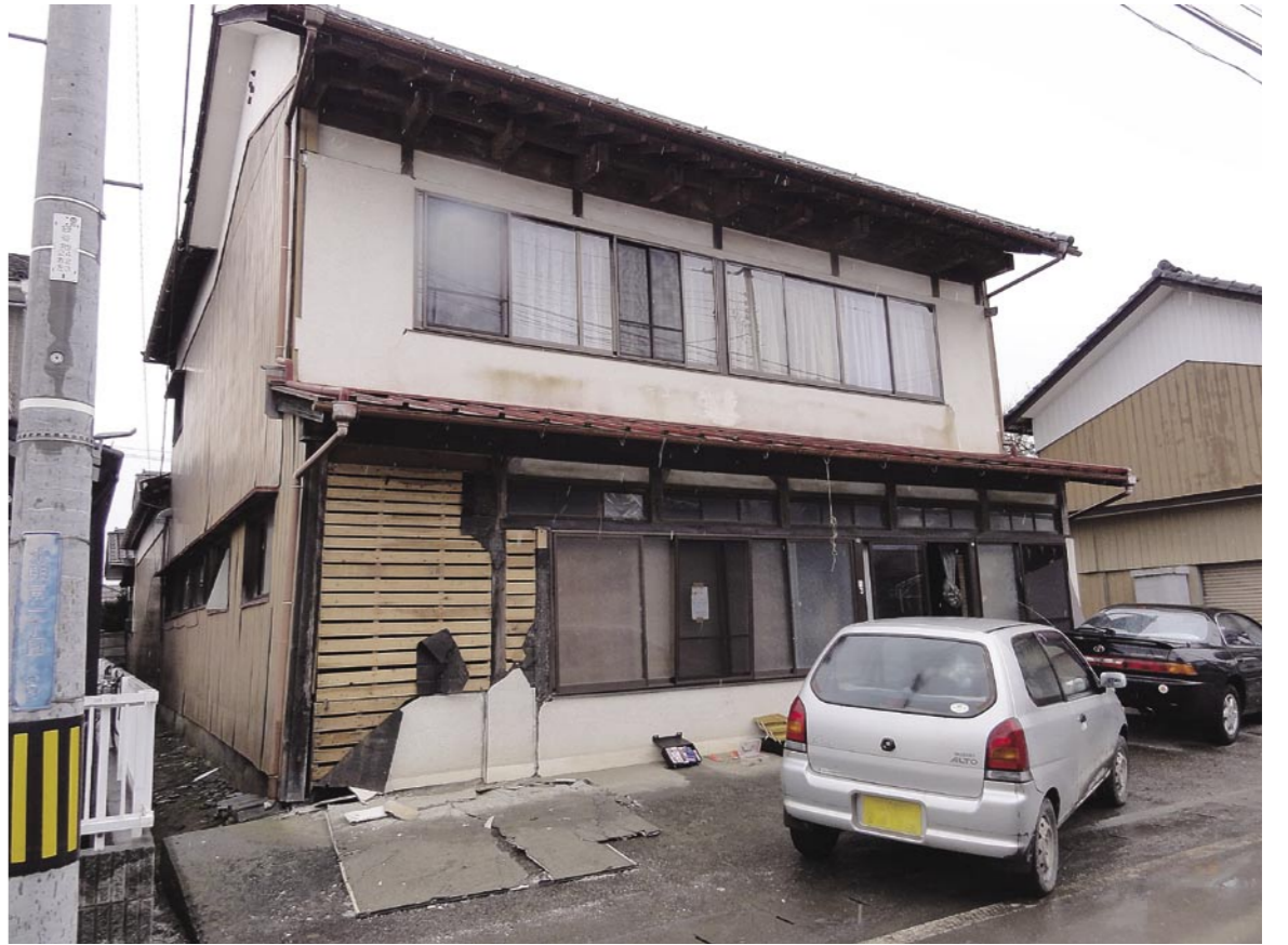
南側に開口部が多いこの住宅では、外装材の一部がはがれて左側面の外壁もゆがみ、応急危険度判定で「危険」と判断された(石巻市。4・5面の他の写真も同)
