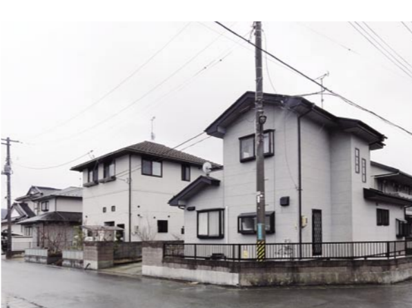
比較的新しい住宅は被害があまり見られない。この一角は床上浸水も免れたという
