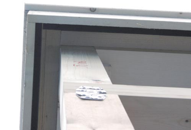
積層プラスチック換気部材を全周に設置している現場。軒天有孔ボードを使う場合も同じように全周設置する
