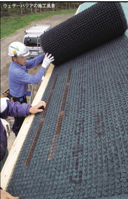
積層プラスチック換気部材を全周に設置している現場。軒天有孔ボードを使う場合も同じように全周設置する
