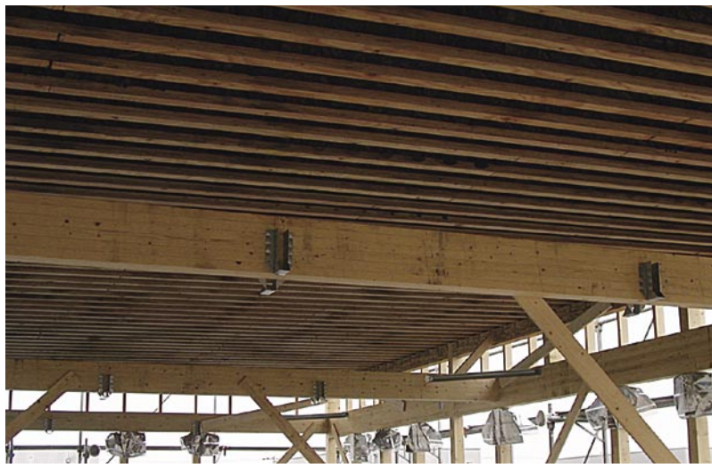
屋根たる木にTJIを採用した現場
