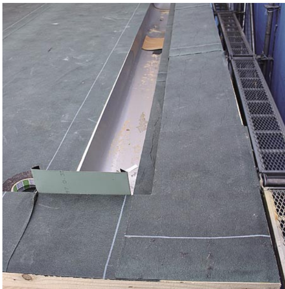
スノーダクト屋根に改質アスファルト系防水シートを使った札幌市のビルダーの現場
