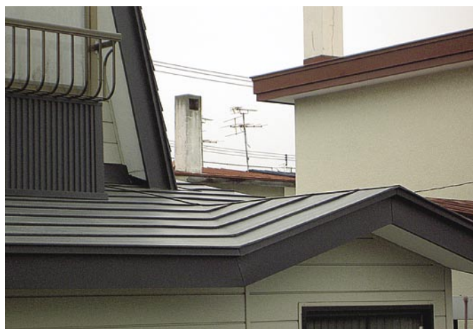
アサヒ金物の水密工法で施工したリフォーム物件
