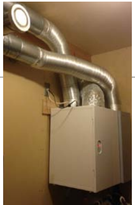
LWZに限らず、配管はスパイラルダクトを使う
