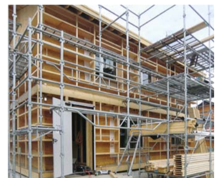
付加断熱下地の施工が終了した構造体
