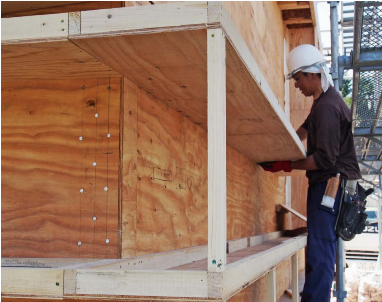
付加断熱下地は 50 × 30mmの栈木2本と幅 310mmの構造用合板 9.5mmを担架状に組み、横使いで躯体に取り付けた
