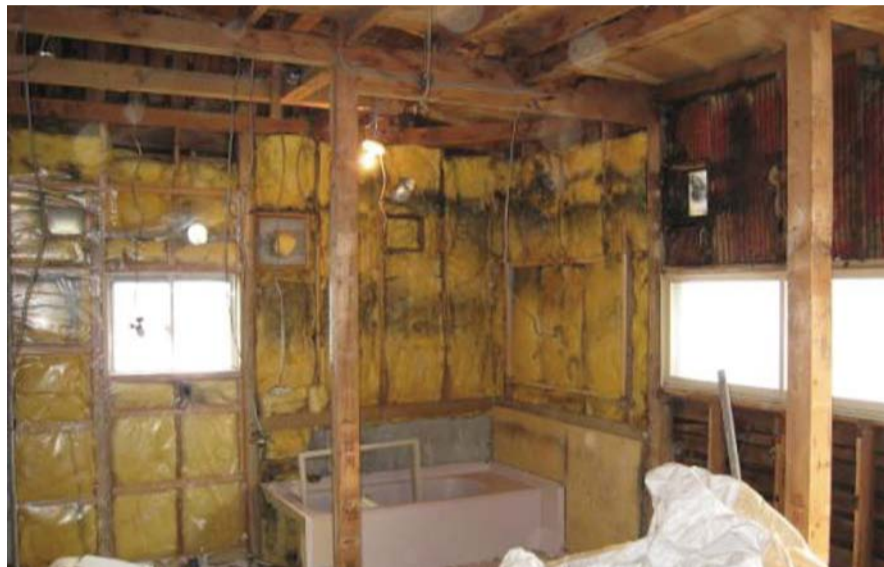
グラスウールのサンプリング調査を行った既存住宅
