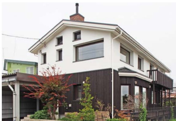
400mm断熱で改修した住宅。窓が室内側に奥まって見えることで、一般的な木造住宅とは違った表情になる
