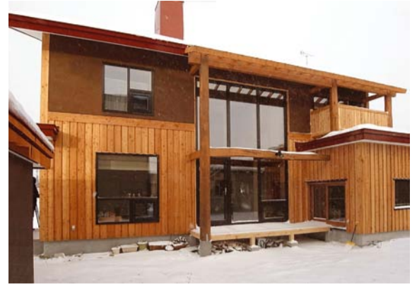
旭川であえて大開口を採用した300mm断熱の住宅
