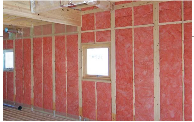
在来木造のグラスウール施工例。軸間にいねいに充填されている
