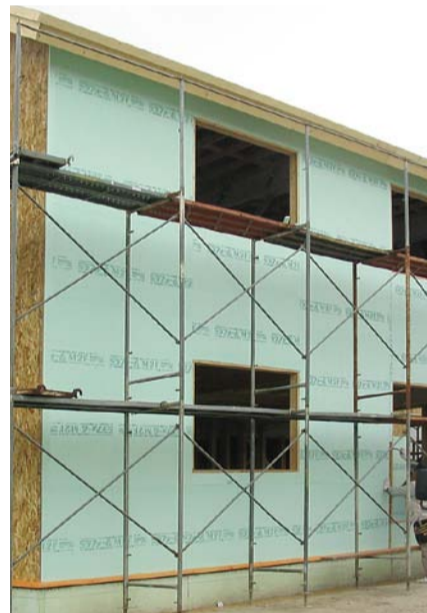
発泡プラスチック系断熱材をメクラ張りして付加断熱を行っている現場
