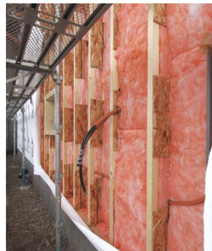
OSBとたる木ではしご状に組んだ190mm幅の付加断熱下地の間にグラスウールを施工している現場
