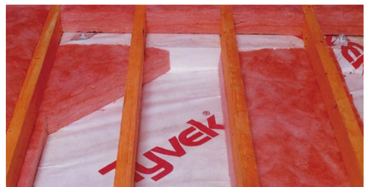
床断熱の施工例。透湿・防水シートで防風処理し、床梁の間でグラスウール100mm、その上の床根太間に同100mmを納めている
