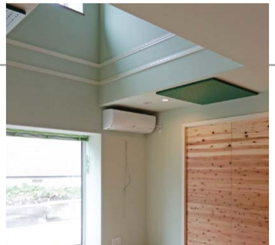
400mm断熱の住宅でエアコン暖房を採用した例。窓もトリプルガラス入り樹脂サッシとしている
