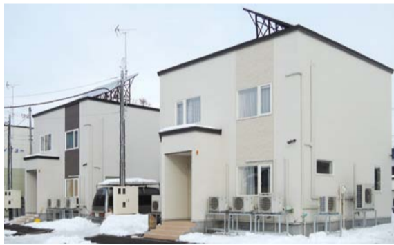
道内に実験施設を設けて寒冷地向けの製品開発に取り組むメーカーも出てきている(写真はダイキン工業の実験施設「ダイキン旭川ラボ」)
