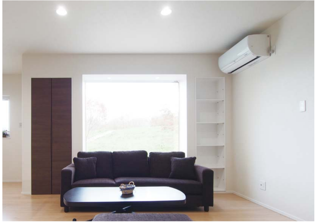
エアコン1台で全室暖房を行っているオホーツク・北見市内の住宅。暖房能力の向上により、外気温がマイナス20℃を下回る地域でもエアコン暖房の採用例が目につくようになってきた
