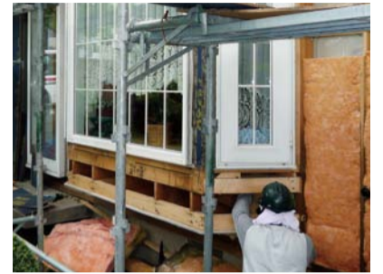
今年度は省エネ改修に対する補助も注目される
