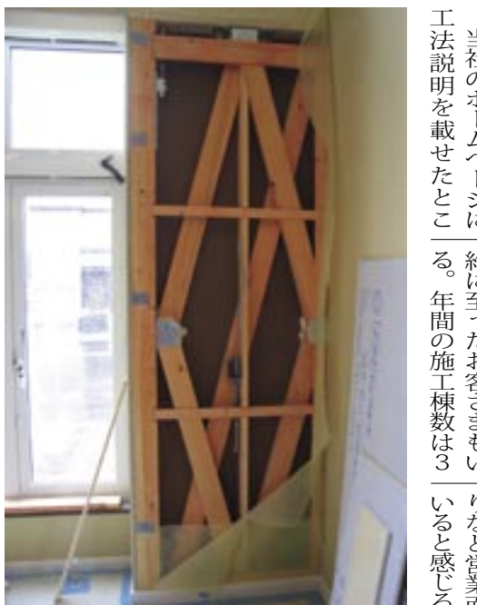
国木ハウスが初めてGVA工法を施工したときの現場
