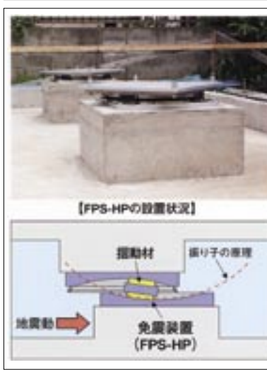
【FPS-HPの設置状況】
