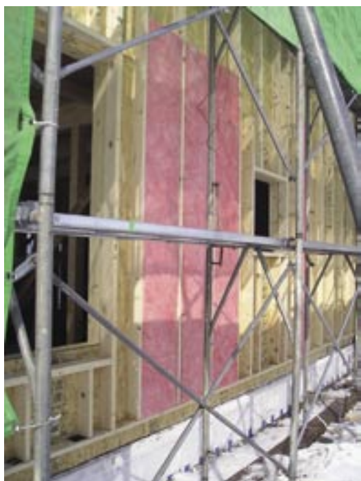
縦使いで構造用合板に留めた間柱材を付加断熱下地とした現場
