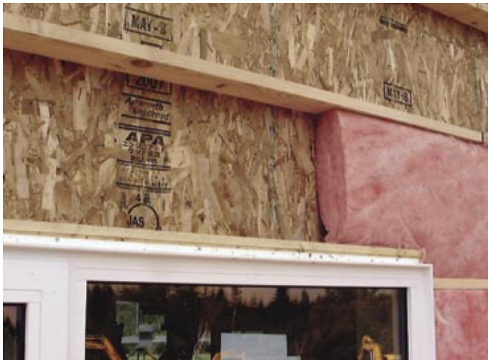
横使いで構造用合板に留めた間柱材を付加断熱下地とした現場
