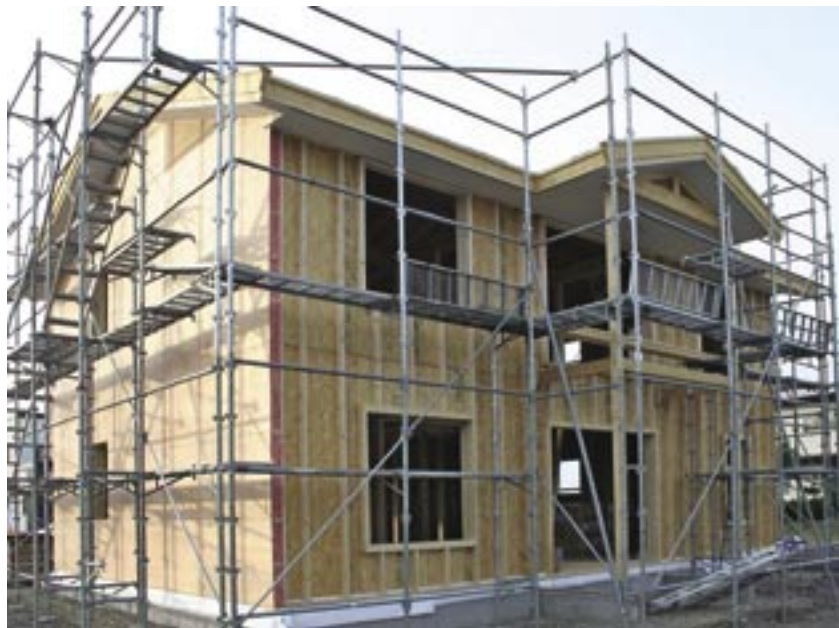
200mm断熱の施工現場。高省エネ住宅は特別なものではなく、誰もが建てられる時代、建てなければならない時代になりつつある
