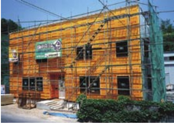
断熱・気密施工を行っている奥野野工務店の現場。気密測定を重ねることによって、今では安定して相当隙間面積0.2~0.3cm 2 /m 2 を記録しているという
