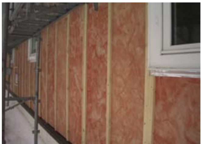
縦桟による付加断熱工法(旭川の現場)
