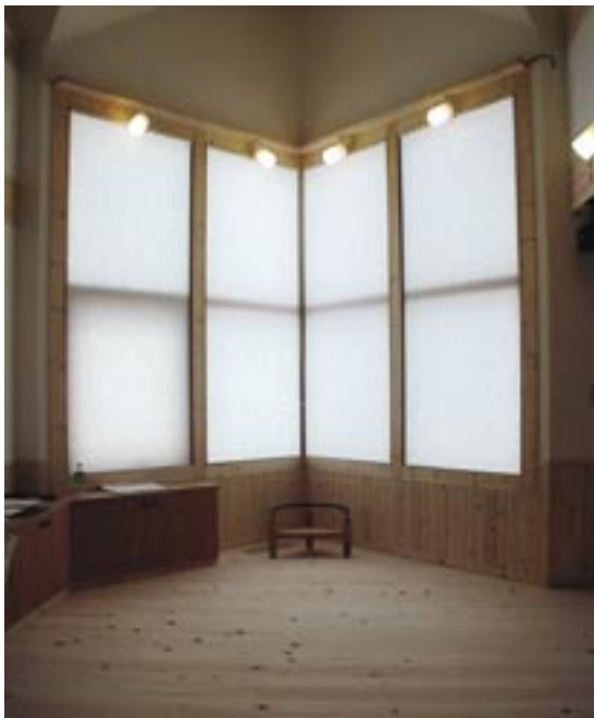
武部建設Q1.0住宅の南面大開口部を室内から見たところ。夜間は断熱ブラインドによって熱損失を抑える
