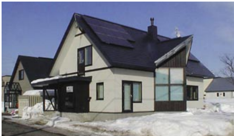
建設が札幌市内に建設したQ1.0住宅。太陽エネルギーの活用を図るため、屋根に太陽光パネルを設置し、南面の突き出し部分に大開口部を設けた
