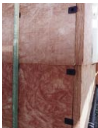
グラスウール外張断熱工法の施工現場。黒い部材が通気胴縁を留めるスペーサー
