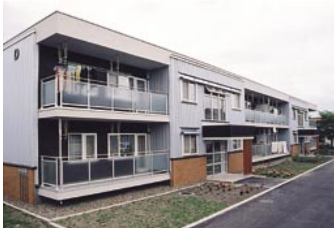
鋼板外装システムを採用した旭川市内の北総研公宅
