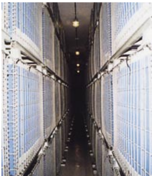
氷冷房で新鮮外気を冷やすのに利用するアイスシェルター
