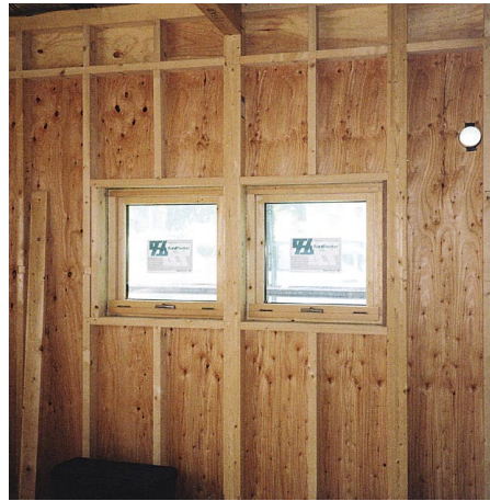
奥野工務店は胴差の下に横材でファイアストップ材を施工。この横材材が内装下地の受け材にもなっている
