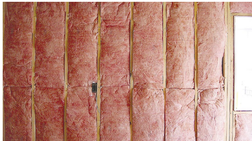
2x6スタッドを使用し、140mm断熱とした住宅
