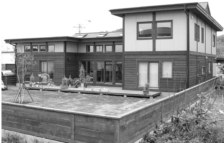
木製窓は縦の線を強調した配置によって住宅を端正に見せることができる
