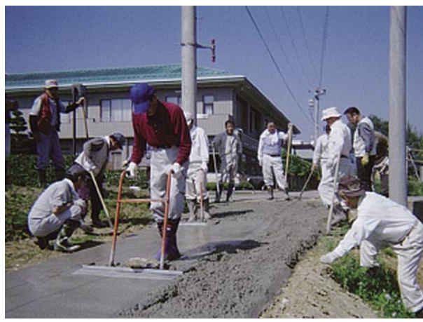
公共事業は削減。村からの支給資材で住民総出の道路舗装を行っている
