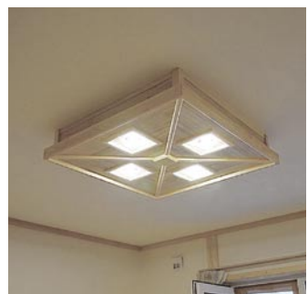
造作した木製の照明ボックスに電球形LEDを4つ配置している
